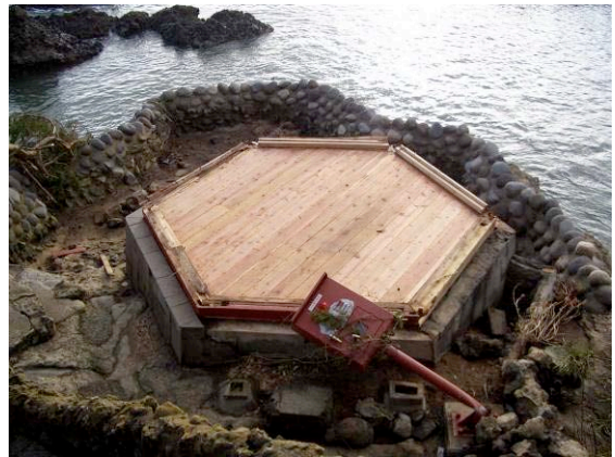
写真1 流失直後の六角堂の台座板
